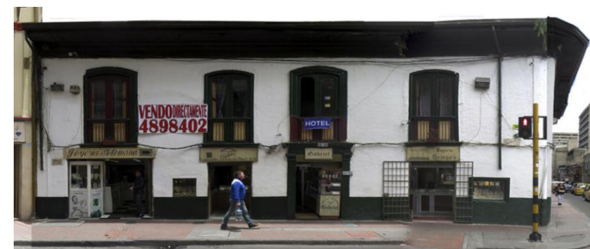
Fuente: Equipo Fotografía PEMP Patrimonio Inmueble
